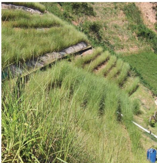
FIGURA 35: Gramínea Vetiver plantado para conter deslizamento em encosta.
