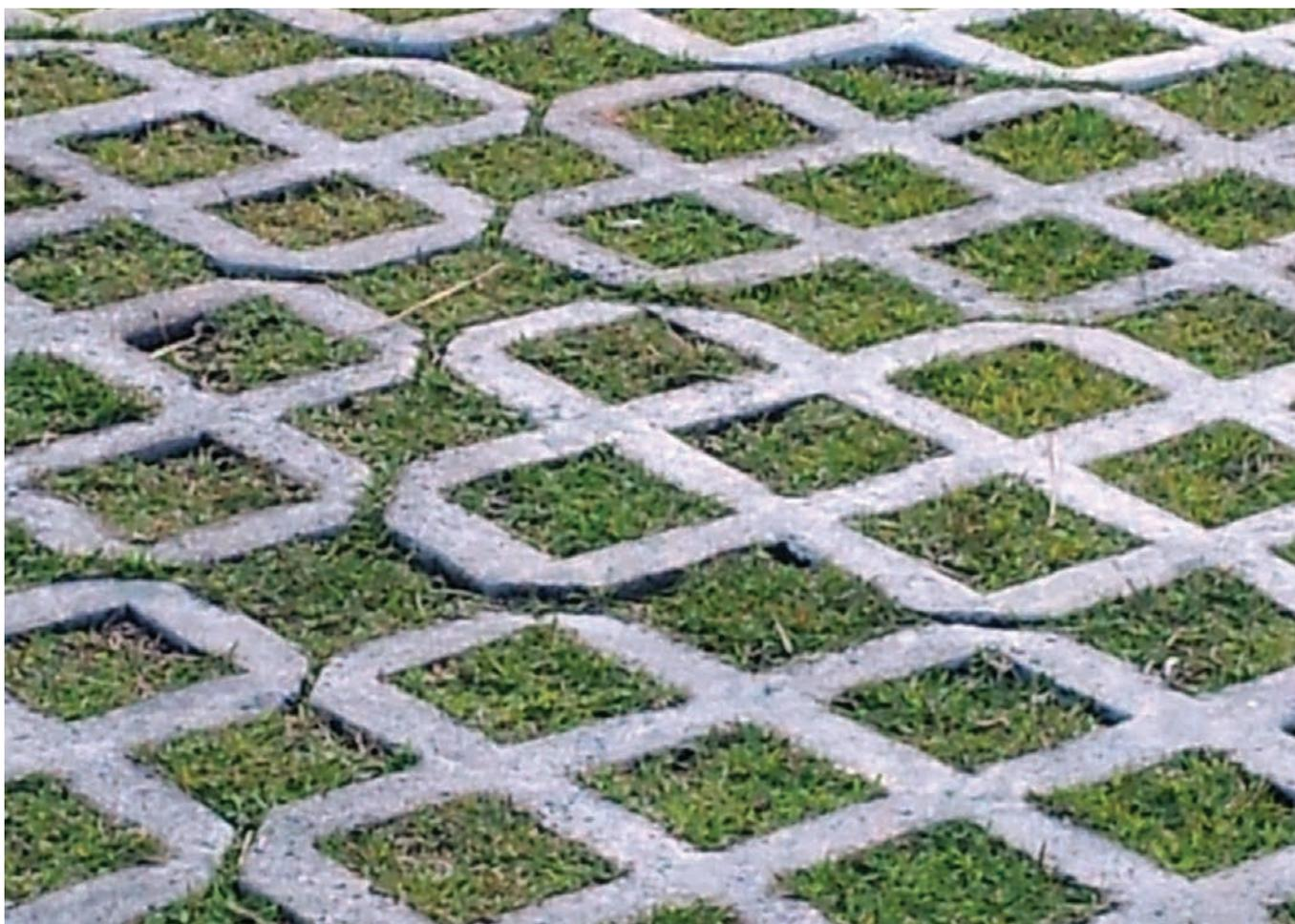
FIGURA 40: Lajota ecológica, que auxilia na maior infiltração de água no solo.
